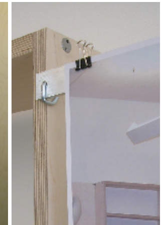
Profilstange und Halter für Vorhänge oder zum Aufhängen von Dokumenten
